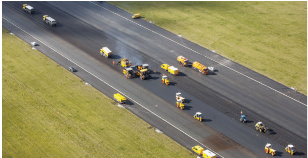
Heijmans asphaltiert die Polderbaan mit Anova® Rejuvenator von Cargill. © 2021 Heijmans
