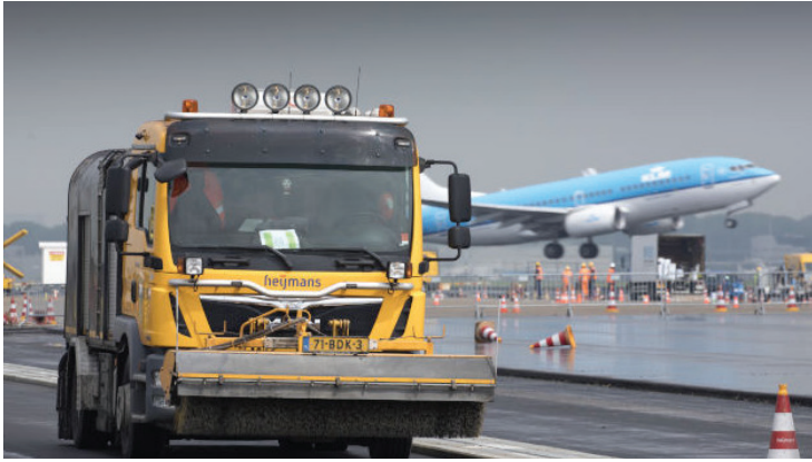
Die verwendeten Produkte mussten leistungsfähig sein: Die Polderbaan sollte so renoviert werden, dass der mit möglichst geringen Auswirkungen auf den täglichen Betrieb von Schiphol. © 2021 Heijmans
