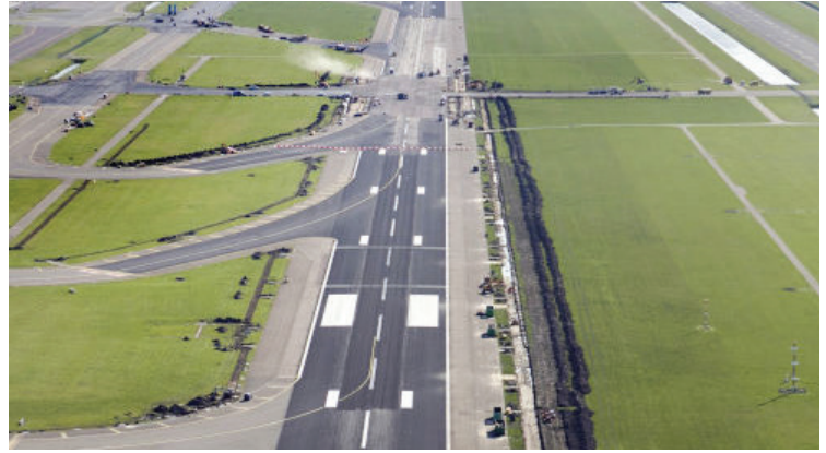
Überblick über das Straßenbauprojekt an der Polderbaan mit dem Anova® Rejuvenator von Cargill. © 2021 Heijmans
